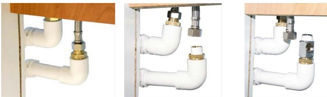
Да се затвори спирателния кран на входящата студена вода към батерията на кухненската мивка. Да се отвие меката връзка, да се почисти и подсуши вътрешната резба на гайката на връзката и външната резба на тръбата. Между тръбата и меката връзка да се навие хромирания присъединител уплътнявайки връзките с тефлонова лента. Лентата да се навива по посока на часовниковата стрелка (на дясно) за да не се изхлзува по време на завиването.
